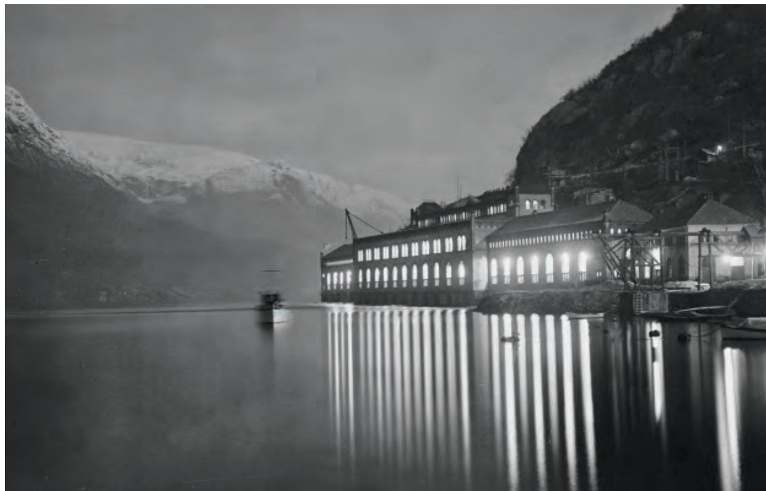
Over: Kraftstasjonen Tyso ved Sørfjorden i Hordaland 1928.
